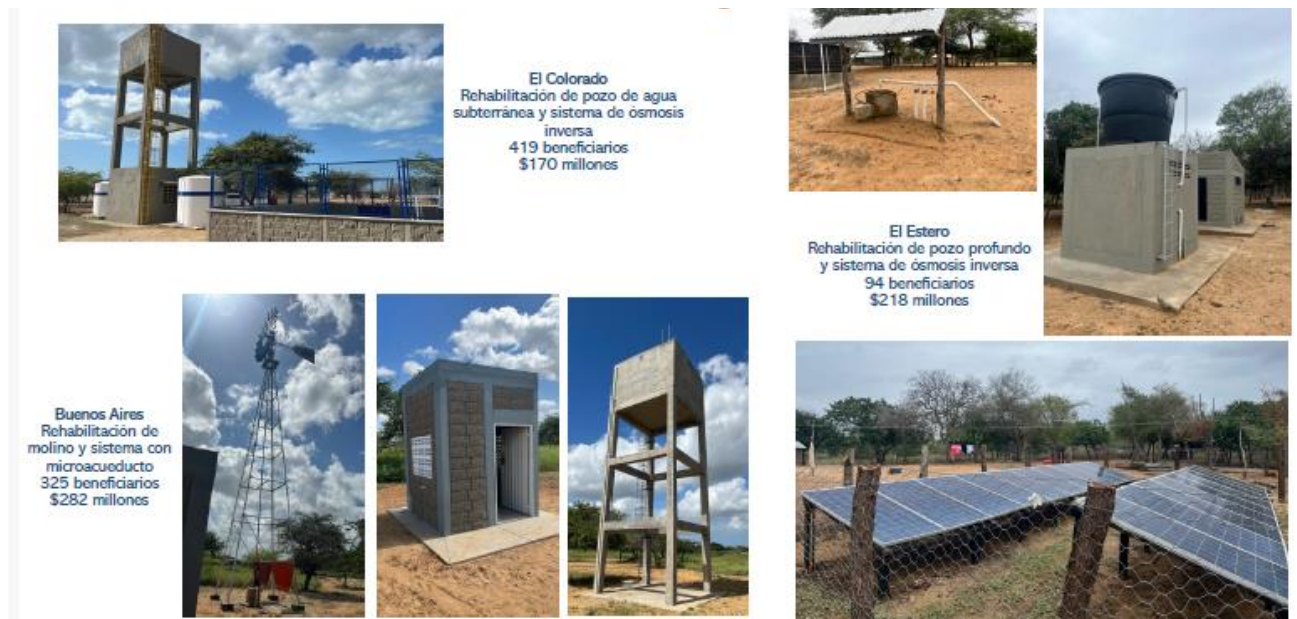
Ilustración 14. Componente 1. Rehabilitación de sistemas de acceso al agua Fuente. Plan Wüin Ülees
